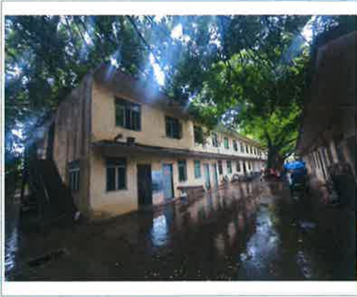
A52-1 宿舍楼外观
