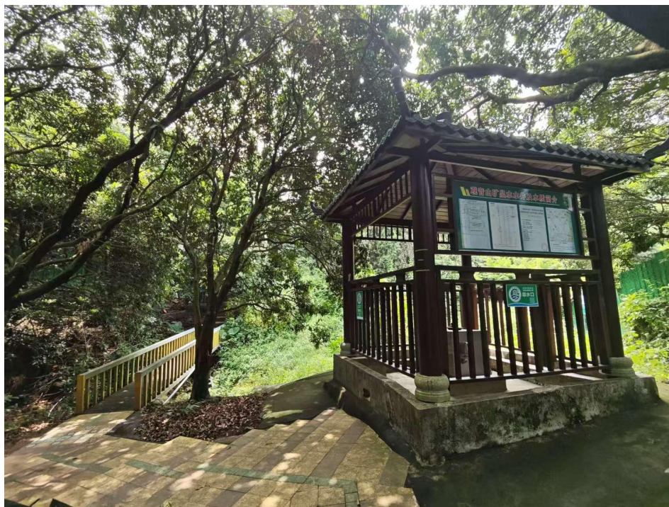
图 2 矿山水井及附属设施（方向：东北向）
