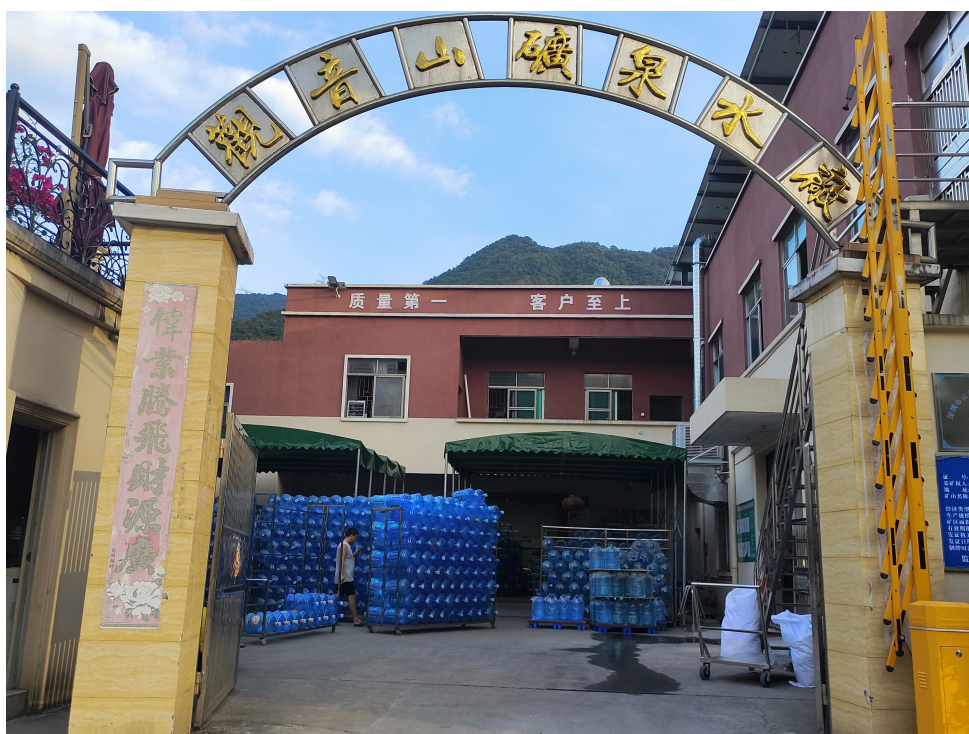
图 3 矿泉水厂（方向：东南向）
