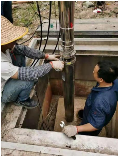
照片 2-2 RJ2 开采井内部结构
